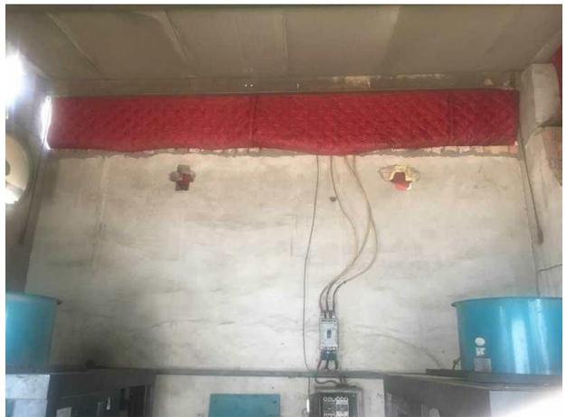
整改后的北侧空压机房（顶部封闭并增加吸音材料）
